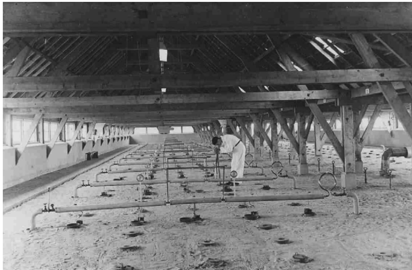
Oliestookinrichting van de steenfabriek De Ooij
