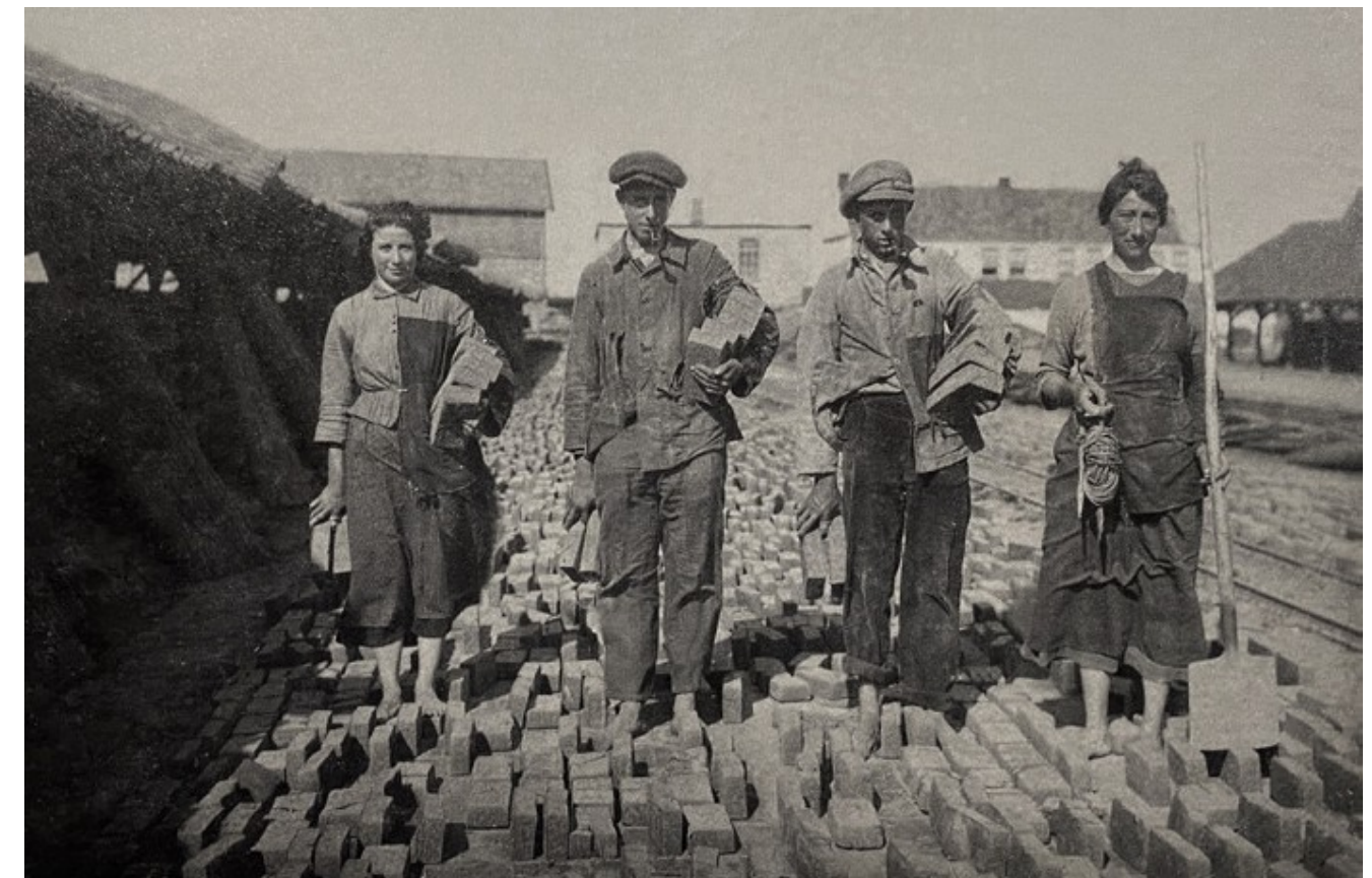
Enkele opsnijders (op blote voeten) op de steenfabriek De Ooij
